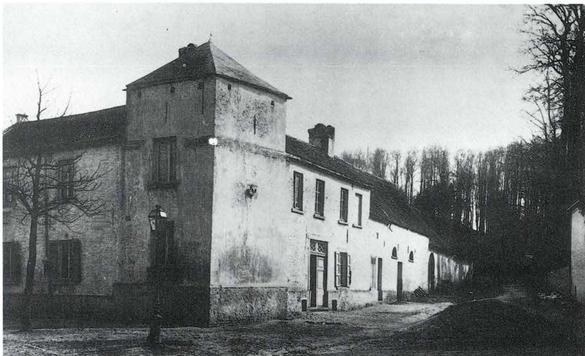
53. Het hof ten Horen in 1892, vóór de «verouderingswerken» van de gebouwen naast de toren (foto, © A.C.L. Brussel).
